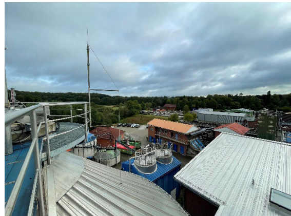
Abbildung 8 - Blick über die Kläranlage
