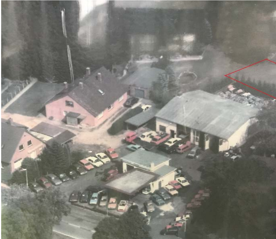
Abbildung 2: Schrägluftbild von 1985 (Quelle: Betrieb Krispin)
