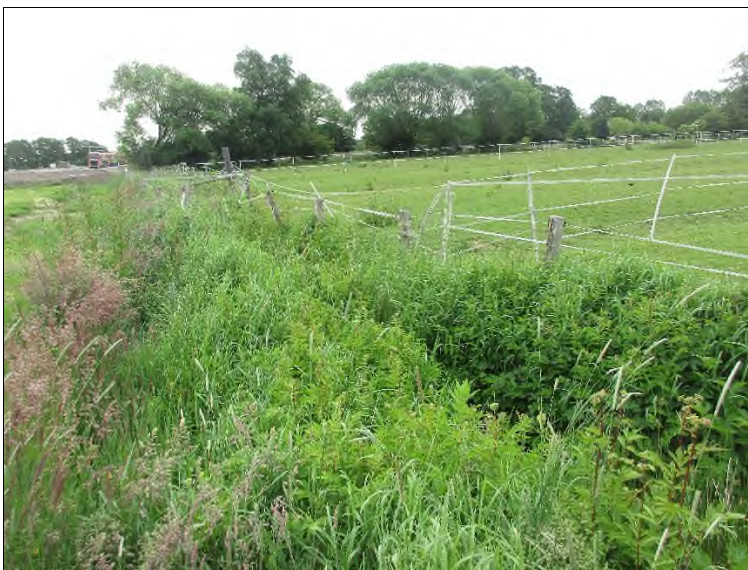
Abb. 5: Graben am Nordrand mit Böschungen mit feuchter Hochstaudenflur
