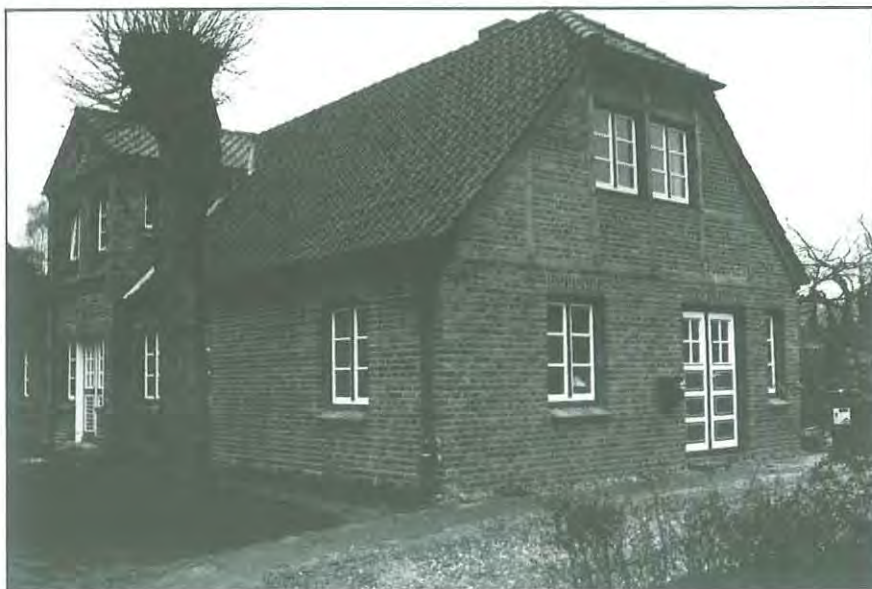
Mauerwerksbau im Schlüskamp
